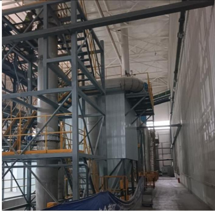
图 3.1-3 ■#窑炉配套除尘设施
