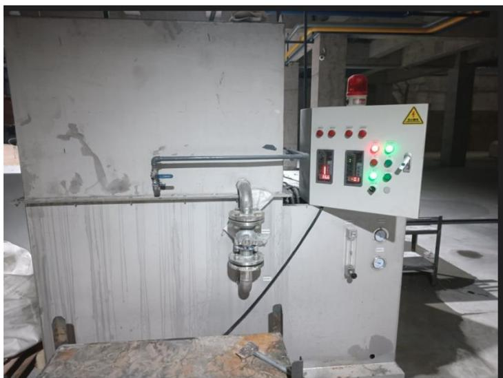
图 3.1-2 #窑炉配套脱硝设施
